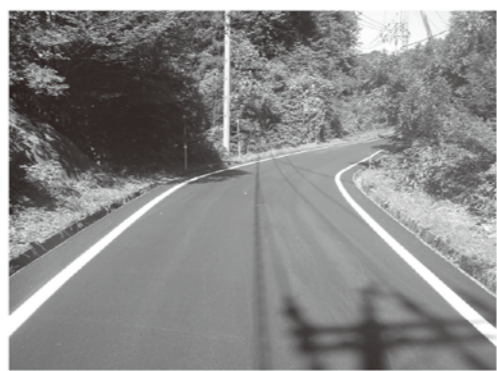
舗装がきれいになった「町道上の谷光峠線」
