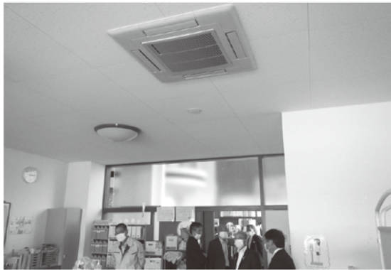
頓原小学校の空調を視察
