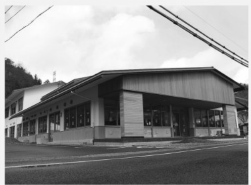
まもなく完成する頓原拠点複合施設
