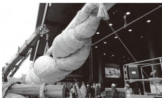
大型クレーンを使ってかけ替えます
