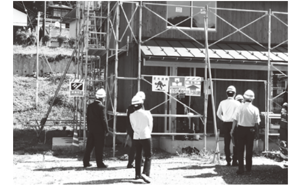
八神里山住宅建築現場
