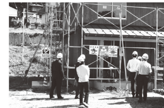
八神里山住宅建築現場
