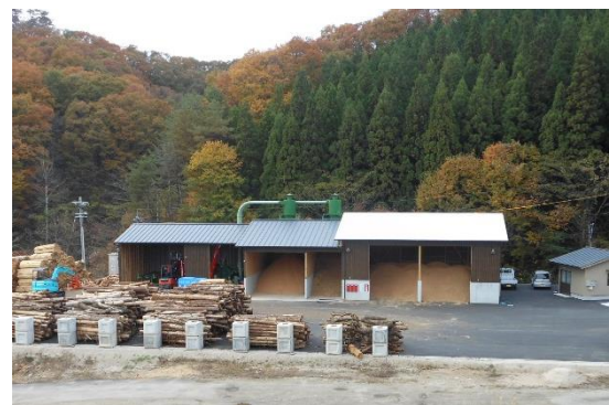
写真1 飯南木質バイオマスセンター
