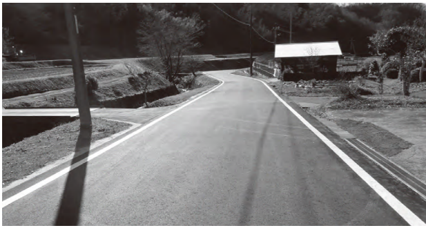
舗装を整備した町道頓原長谷線
