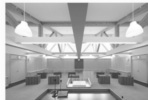
議場入口から見る木造のトラス
