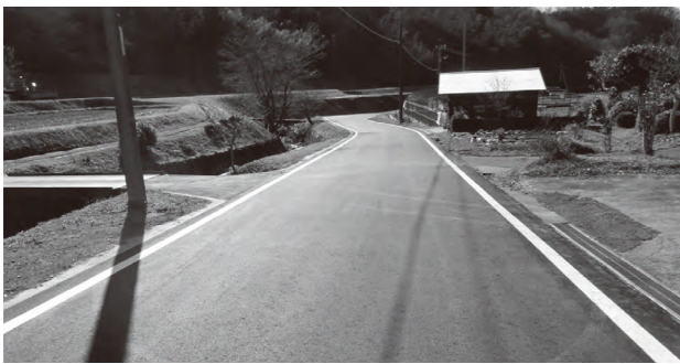
舗装を整備した町道頓原長谷線
