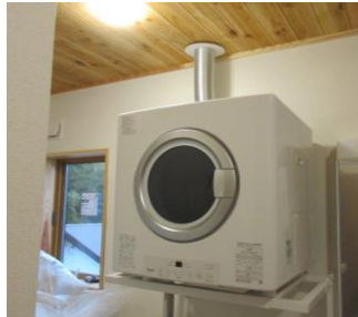
ガス衣類乾燥機取付
