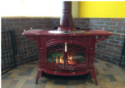
飯南町庁舎へ薪ストーブ設置
