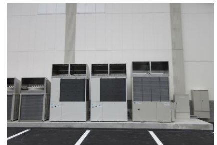
来島複合施設へガス空調設備設置
