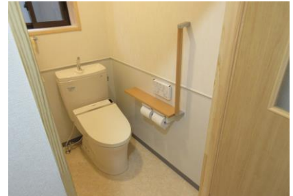
リフォーム工事（節水型トイレ）
