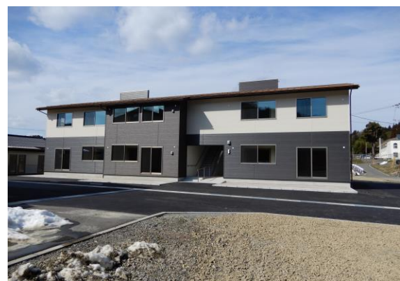
施工実績：新衣掛団地
