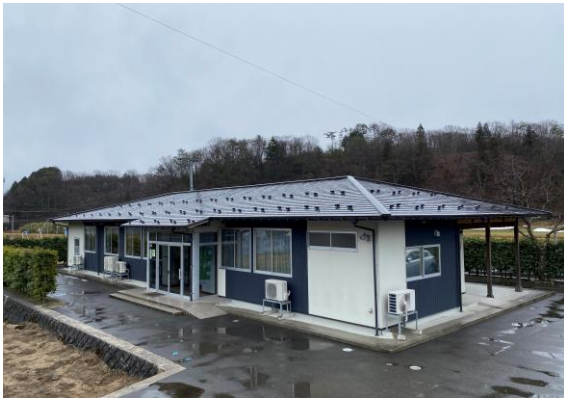
正木建設 本社建物
