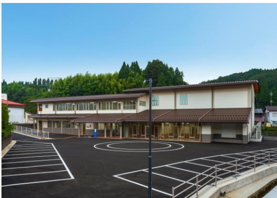
施工実績：みんなの広場 来島交流センター
