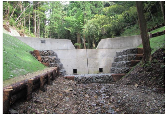
施工実績：溪間工事
