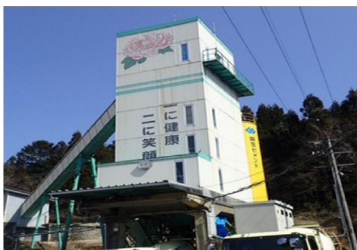
生コンプラント工場
