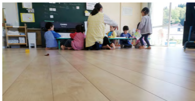
保育所の床の張り替えを行いました
