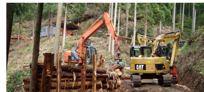
プロセッサによる造材、グラブプルによるはき積み
