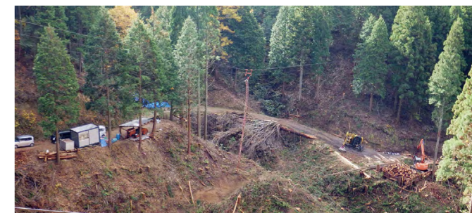
集材機を使用して土場に材を運ぶ様子
