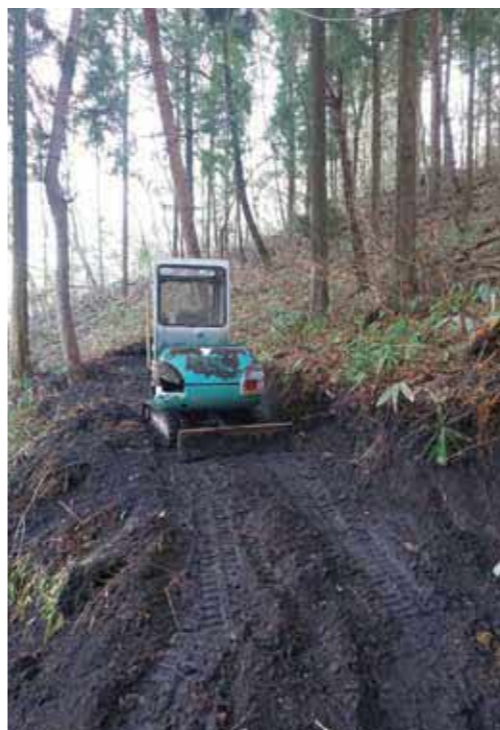
木材搬出路の整備
