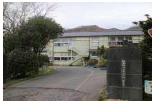
耐震診断をする志々小学校
