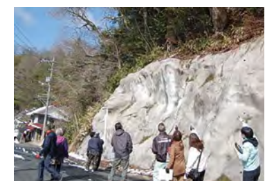
普段通る道にも危険箇所が
