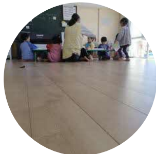
保育所の床板を全面張替え
