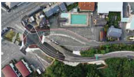
頓原長谷線（頓原交差点付近）
