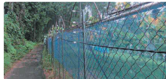
侵入防止柵の設置
