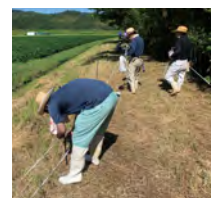
地域ぐるみで行う電気柵の設置
