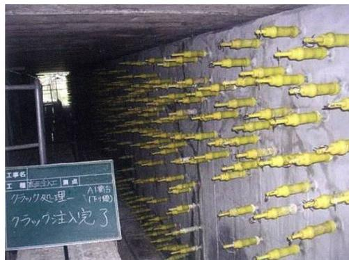
写真 5-2 ひび割れ注入状況
