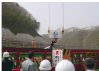
志津見ダム初打設式
