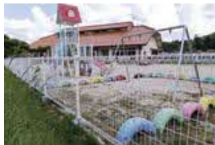
保育所の遊具や駐車場整備
