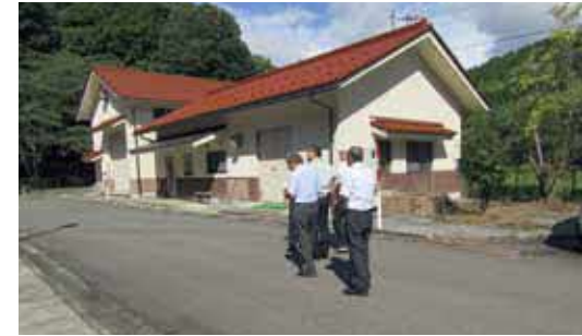
太陽光パネル設置予定の浄化センター
