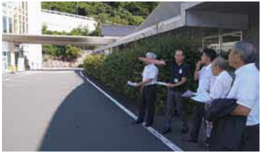
飯南病院玄関改修現場
