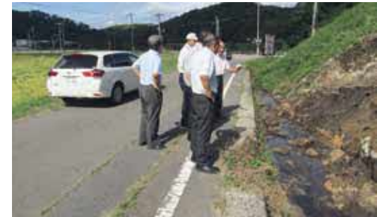
8月豪雨災害の発生箇所
