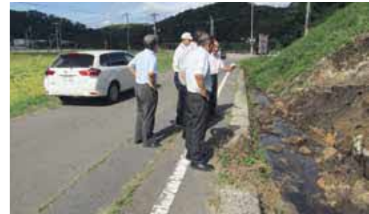
8月豪雨災害の発生箇所
