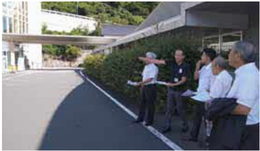
飯南病院玄関改修現場
