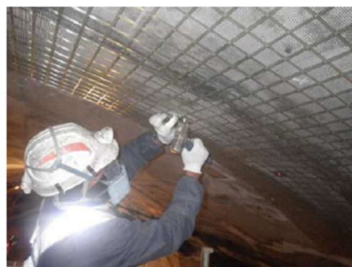
写真 3-1 FRP ネット設置状況
