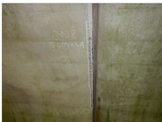
覆工（側壁）からの漏水
