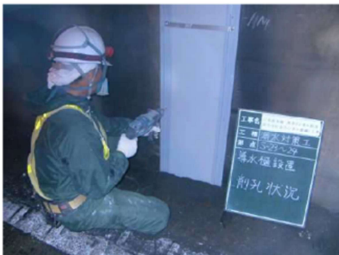
写真 3-2 線導水工
