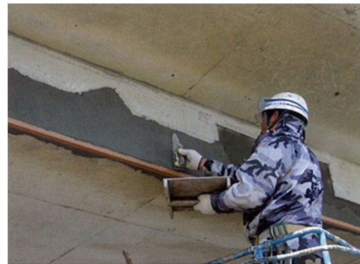
写真 5-3 断面修復状況
