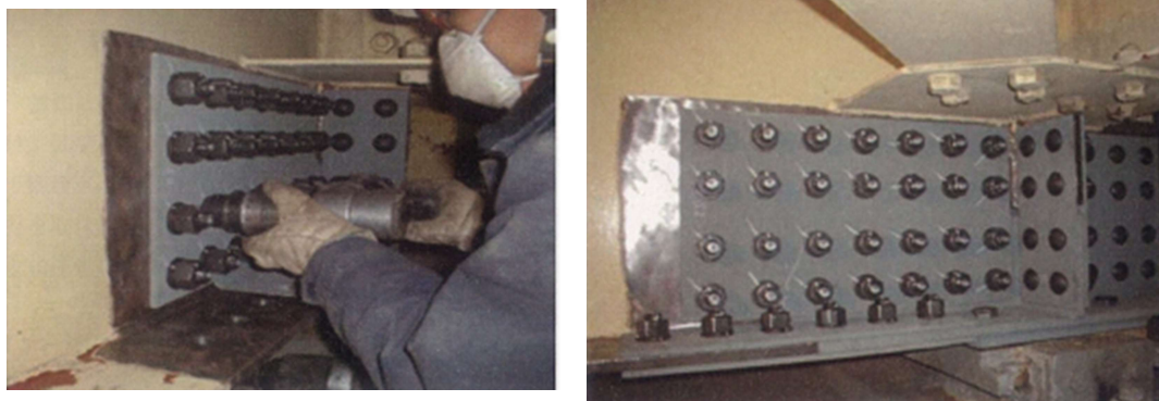
写真 5-1 当て板工実施状況
