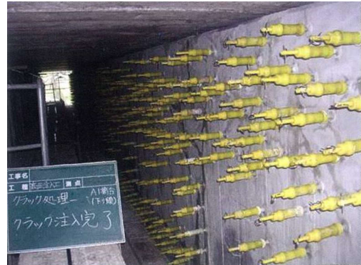
写真 5-2 ひび割れ注入状況
