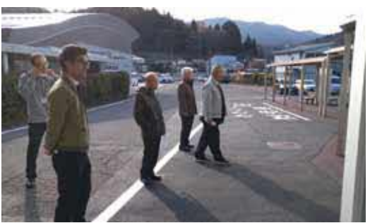
工事が完了した病院玄関を視察
