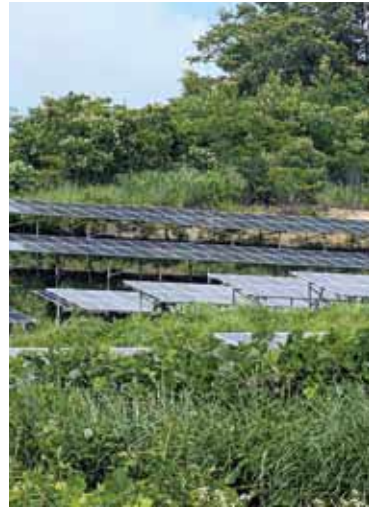
町内の大規模太陽光パネル
