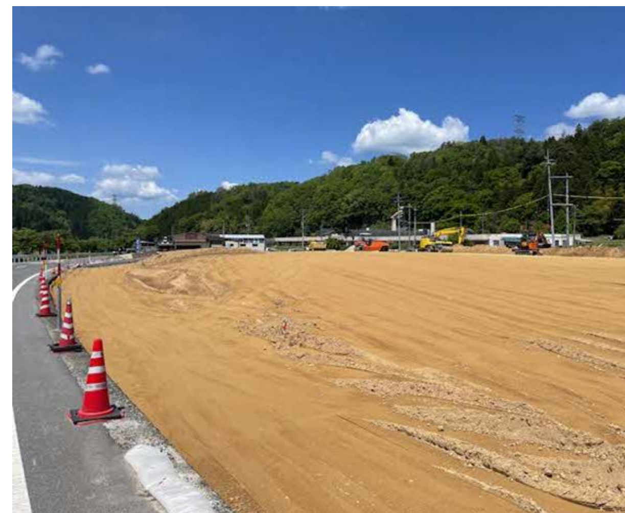
造成工事の様子
